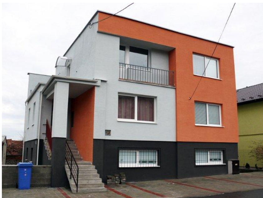
budova zdravotného strediska po rekonštrukcii
