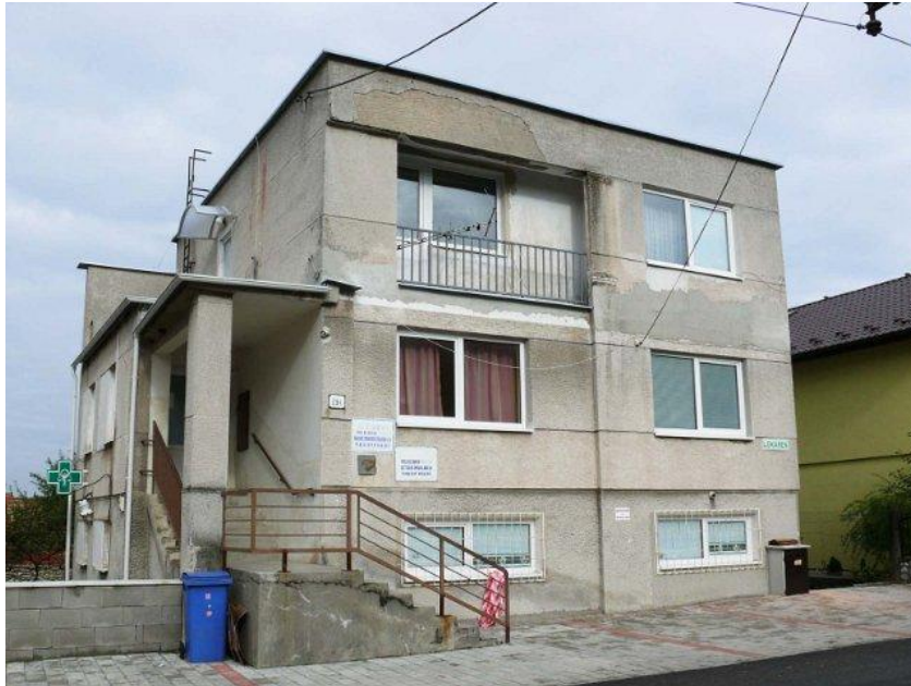
budova zdravotného strediska pred rekonštrukciou
