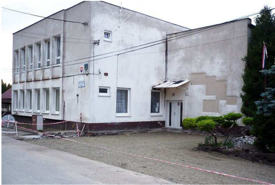
budova OU pred rekonštrukciou
