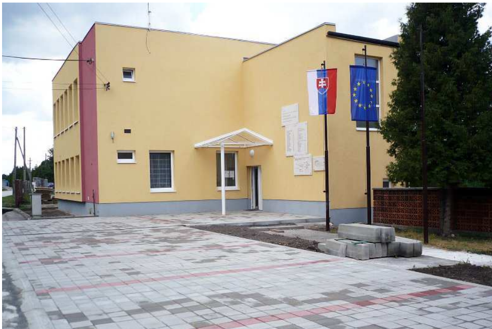
budova OU po rekonštrukcii
