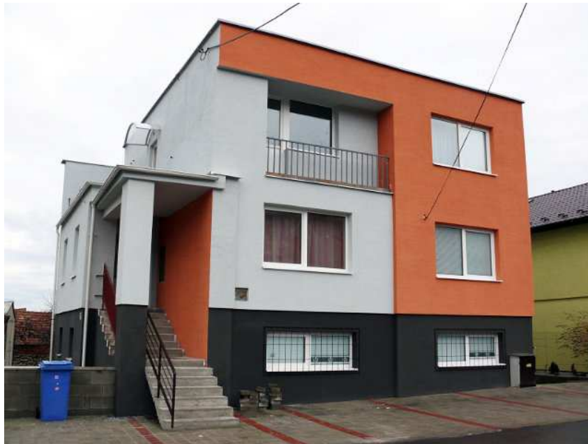
budova zdravotného strediska po rekonštrukcii
