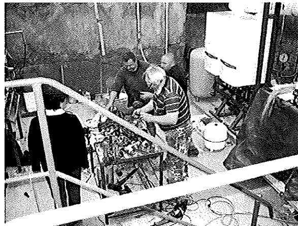
rekonštrukcia budovy ZŠ
